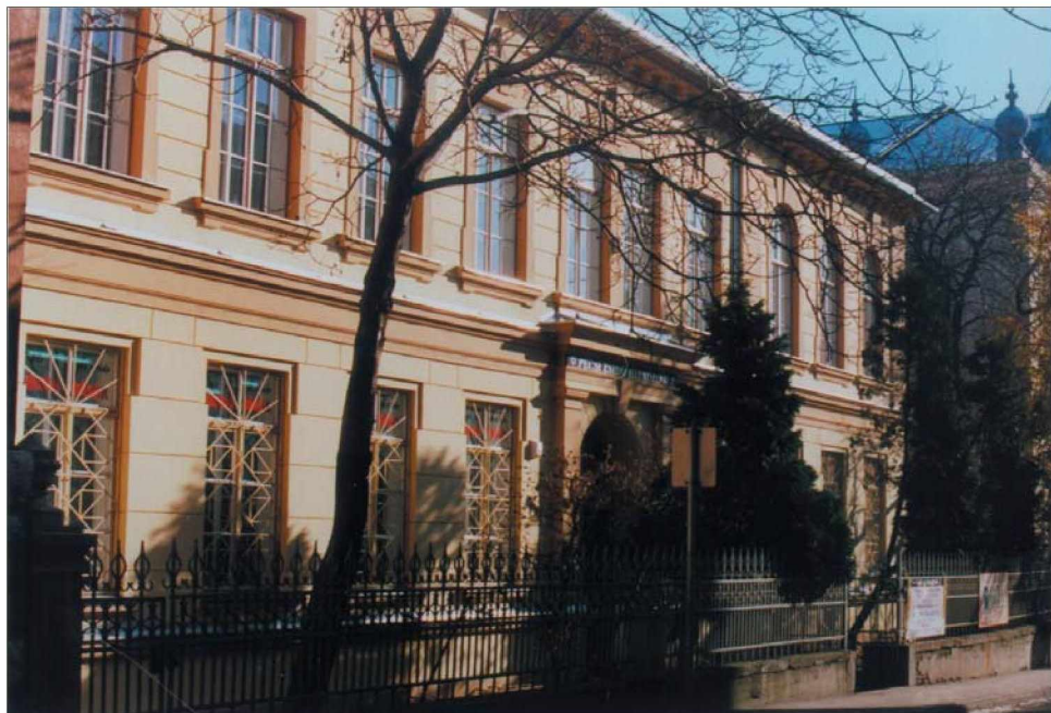
Az egykori iskolaépület fürdő utcai homlokzata 1999-ben
