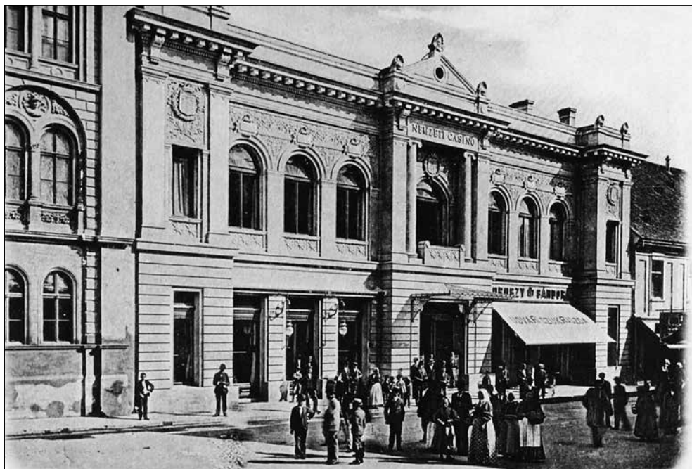
A Nemzeti Kaszinó épülete
