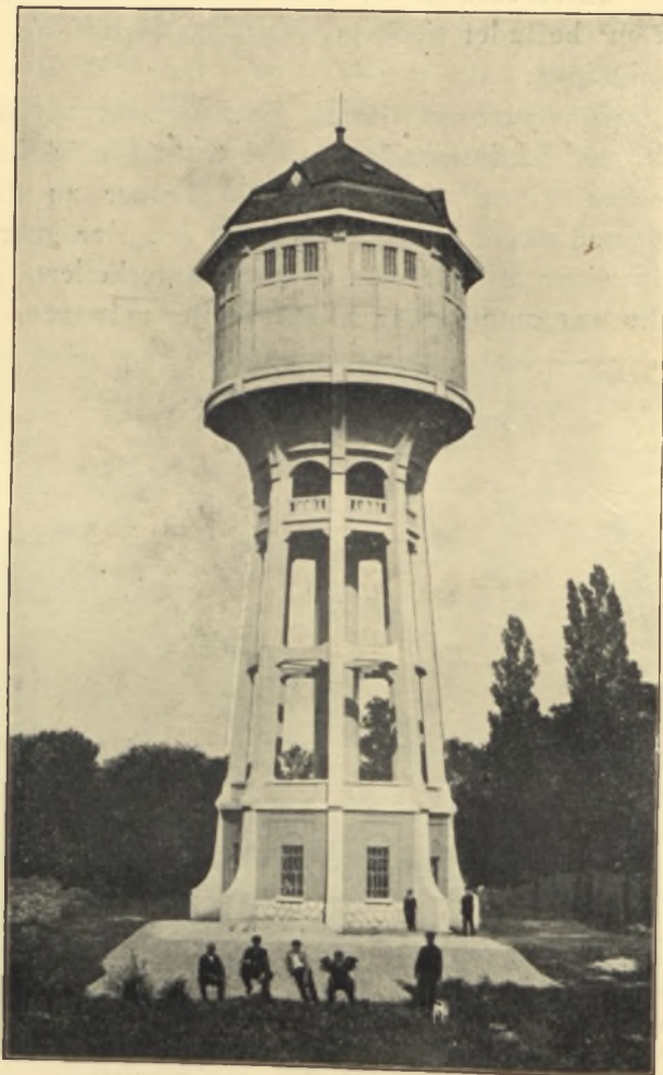
Abb. 37. Wasserturm auf der Meszespuszta.
