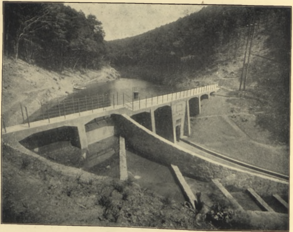
Abb. 42. Eisenbeton-Stauwerk in Vasas.
