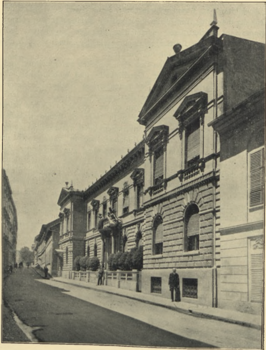
Abb. 47. Direktionsgebäude in Pécs.
