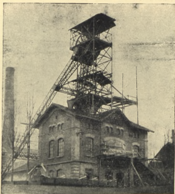
Abb. 41. Neues Fördergerüst am Thommen-Schacht vor der Abtragung des alten.
