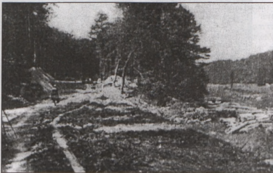
Szerpentin bekötőút építése az országúttól a fürdőig
