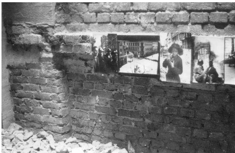
Varsó, fotókiállítás az épülő prímási palotában
