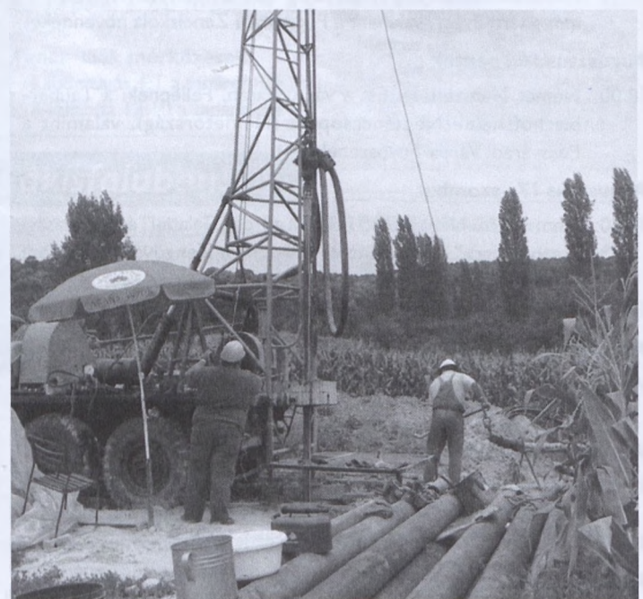
Fúrják a 72 méter mély ivóvízes kutat a Mali-kertben. A köves talaj miatt a munka lassan halad, de még augusztusban befejezik a munkát, kicsövezik a kutat. Az évről évre visszatérő vízhiány miatt döntött úgy városunk képviselő-testülete, hogy újabb kutak fúrásával megoldja ezt a problémát
